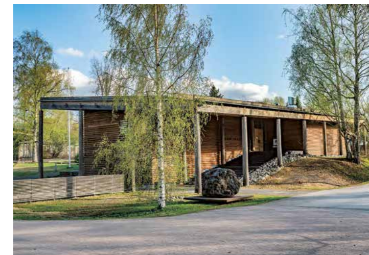
Juminkeon näyttävyttä lisäävät turvekattoa kannattelevat hirsipilarit.
